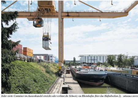
Jeder vierte Container im Ausserhandel erreicht oder verlässt die Schweiz via Rheinhafen (hier das Hafenbecken 2). sbbas.com
