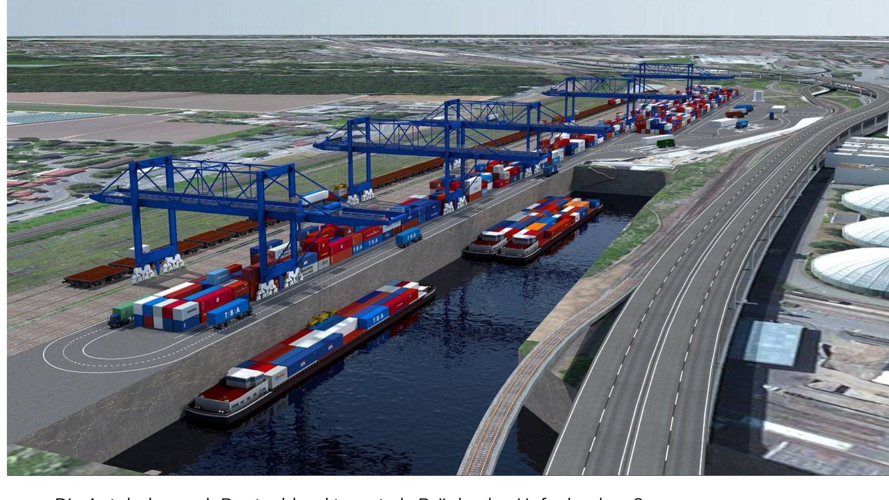
Die Autobahn nach Deutschland trennt als Brücke das Hafenbecken 2 vom neuen Hafenbecken 3.
