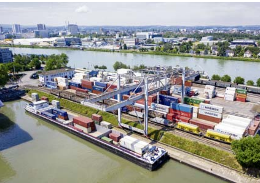
Containerterminal in Basel-Kleinhüningen.
