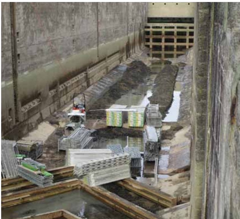
Auch auf dem schweizerischen Rheinabschnitt fanden im laufenden Jahr Revisionsarbeiten statt. Bei der Schleuse Augst wurde vom 4. bis 24. März eine Ankerkontrolle der Schleusenwände durchgeführt. Dazu musste die Schleuse leergelassen werden. Es wurden auch die Dichtungen am Untertor ersetzt. Foto: Kraftwerk Augst.
