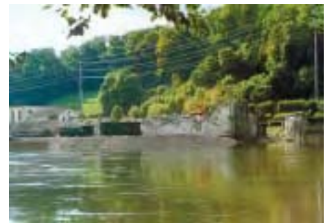
KW Ruppoldingen: das alte Maschinenhaus wird zu Gunsten eines Umgehungs gewässers abgebrochen.
