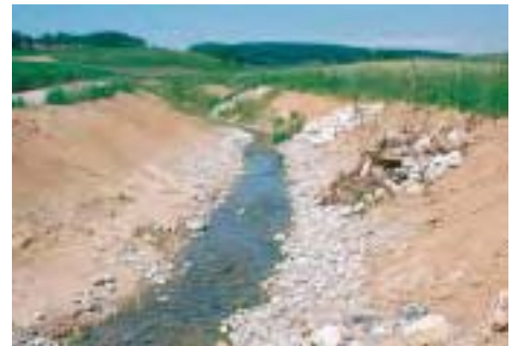
Ersatz: Diese Bachausdolung wurde als Ersatz für Eingriffe realisiert, die durch den National- strassenbau zwischen Henggart und Andel- fingen erfolgten. Rechts: Stein- und Ast- haufen als Lebensräume für Reptilien. Derar- tige Kleinbiotope machen nur Sinn, wenn sie für das Gebiet typisch sind (vgl. Kap. 3.1.5.10). Foto: ökonsult
